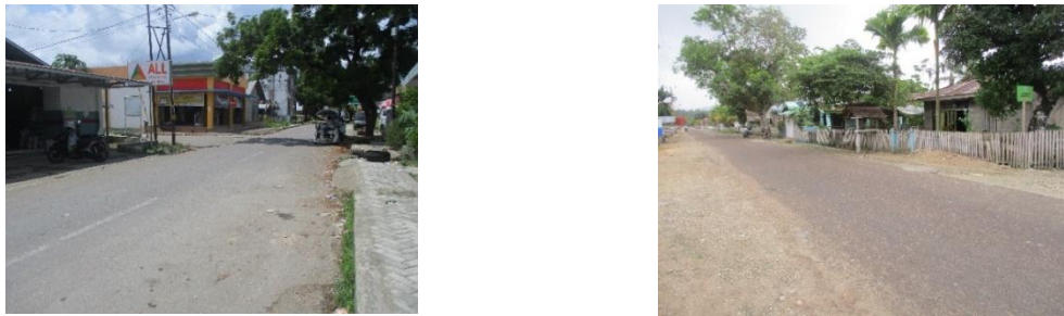
Gambar 4.28 Kondisi Jalan di Kabupaten Banggai Kepulauan
